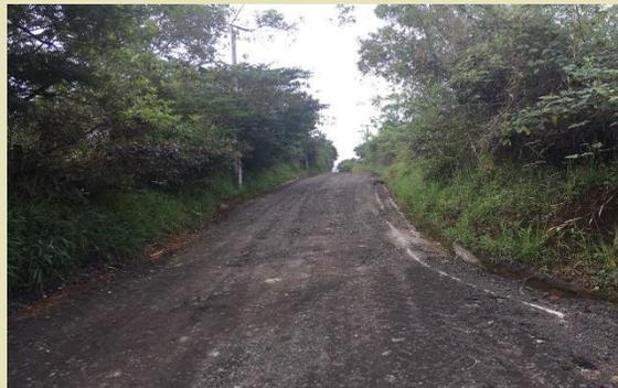
Desde el mes de marzo se adelantan distintas actividades de mantenimiento de la vía. Después de la Asamblea General, se logró contratar una motoniveladora y un rodillo compactador que se encontraban en la zona, para adelantar la conformación y compactación de algunos tramos.
